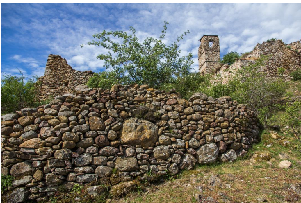
Mur construït amb la tècnica de la pedra seca a La Bastida
