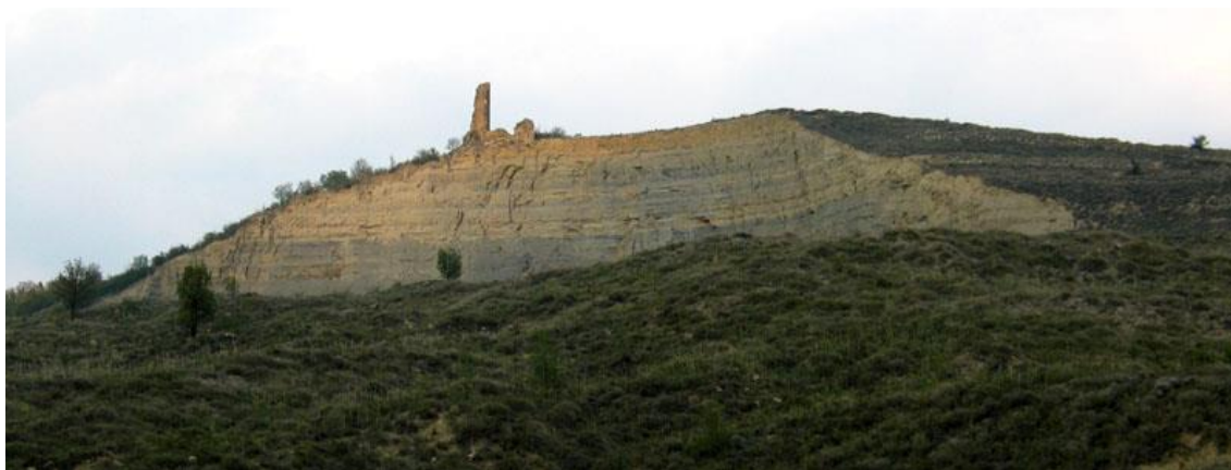
El desprendimiento de Puigcercós
