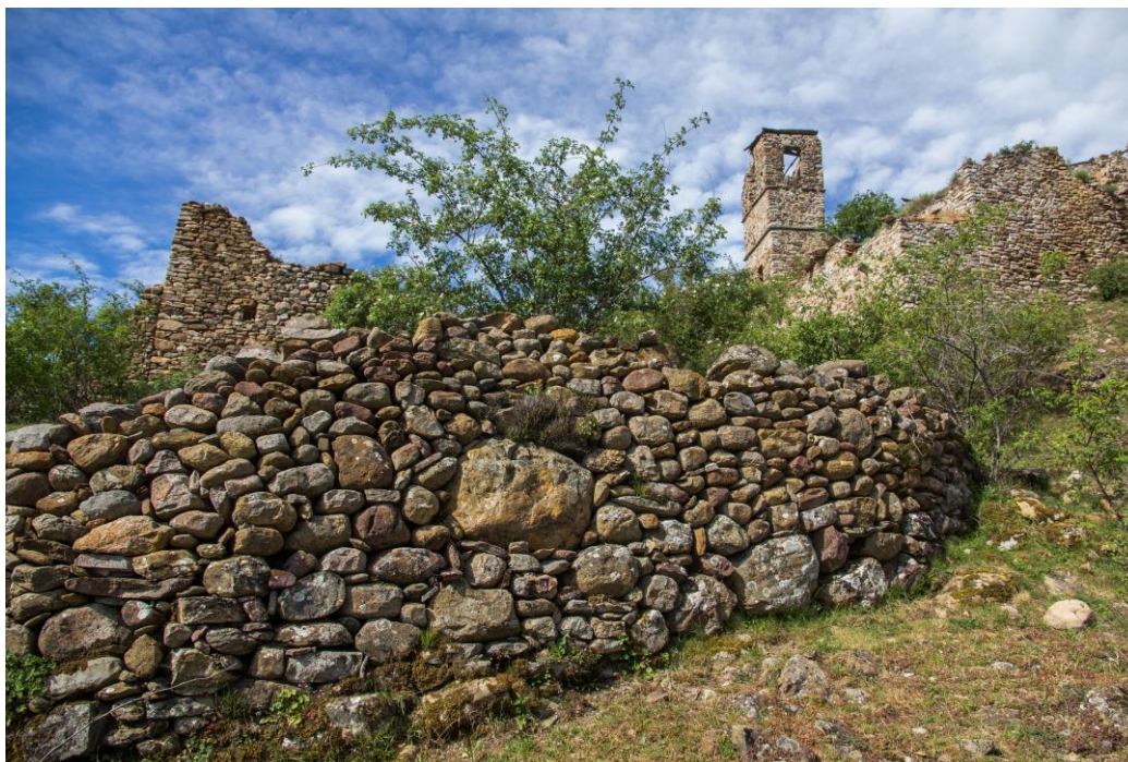
Muro construido con la técnica de la piedra seca en La Bastida
